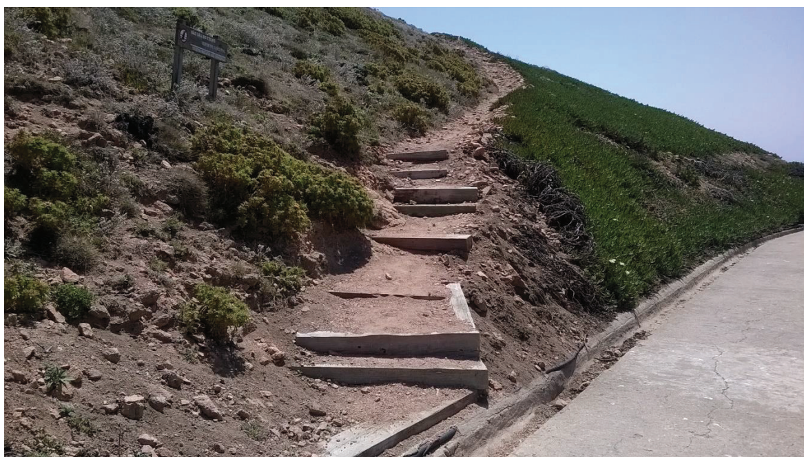
Figura 42_Obra de consolidação no início do trilho de acesso à Ilha Velha.
