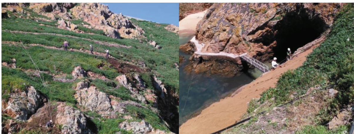
Figura 16_ Segunda passagem nas faixas da vertente oeste do Carreiro do Mosteiro (janeiro 2017) e colocação da manta de coco (maio 2017).
